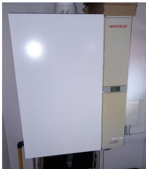
Slika 4.1: Kondenzacijski kotel za novi del
