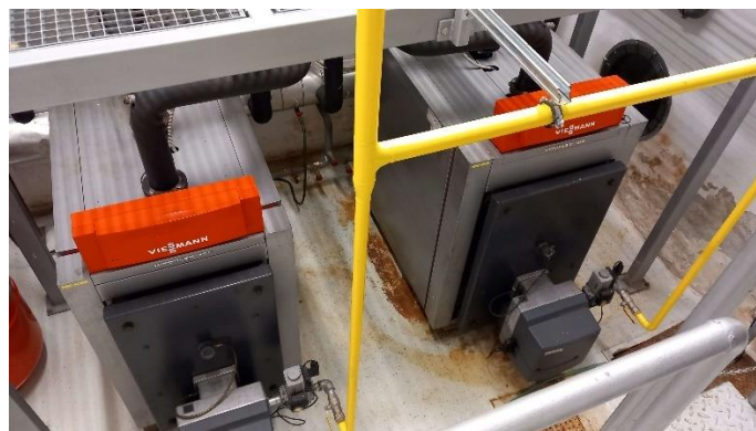
Slika 4.2: Nizkotemperaturna kotla za stari del
