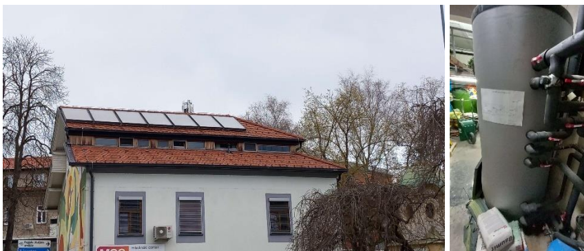
Slika 4.3: Sončni kolektorji in hranilnik za TSV za novi del
